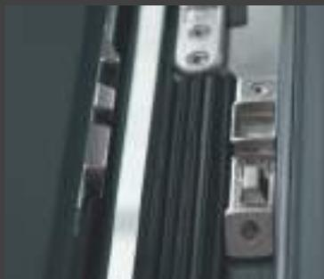
**Les pènes anti-dégondage** sont un accessoire qui renforce la protection de la porte contre l'effraction. Elles sont montées du côté des charnières, sur le battant et le bâti. En fonction du degré de sécurité requis, vous pouvez en utiliser différents nombres pour un battant.
