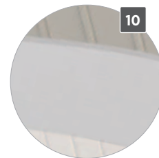
Isolation en polystyrène
