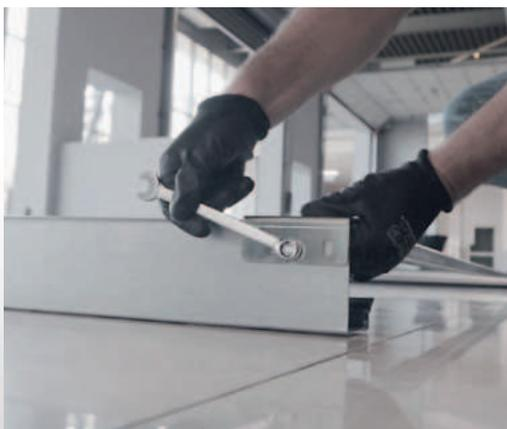
**La traverse arrière** – est en tôle d'acier de 2 mm d'épaisseur avec les cornières métalliques elle forme un élément stabilisateur très solide. Il s'agit également d'un gabarit qui permet de déterminer correctement et rapidement l'espacement des bâtis.
