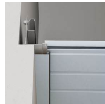
Pose dans la baie - le cache derrière la baie
