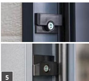
5 Dispositif anti-chute du vantail.
